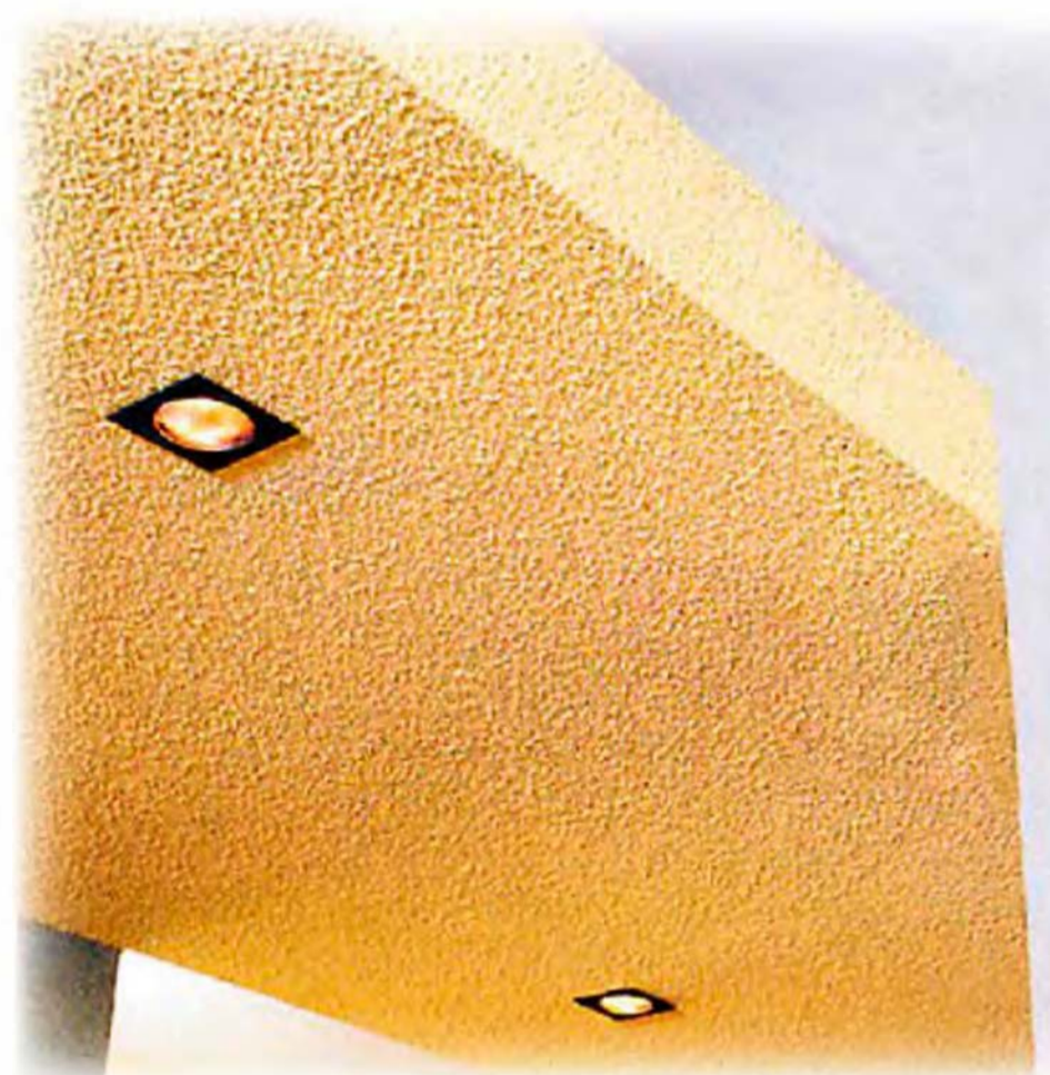
Подвесной потолок со встроенными светильниками.
