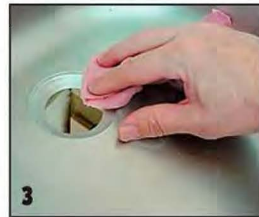
После демонтажа старого сифона тщательно очищаем мойку вокруг выпускного отверстия.
