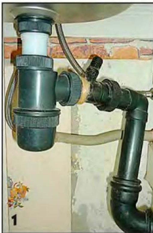
При замене сифона убираем всю старую подводку от мойки до раструба канализационной трубы. Тем более, что патрубок для подключения сливного шланга стиральной машины нам в дальнейшем не понадобится.
