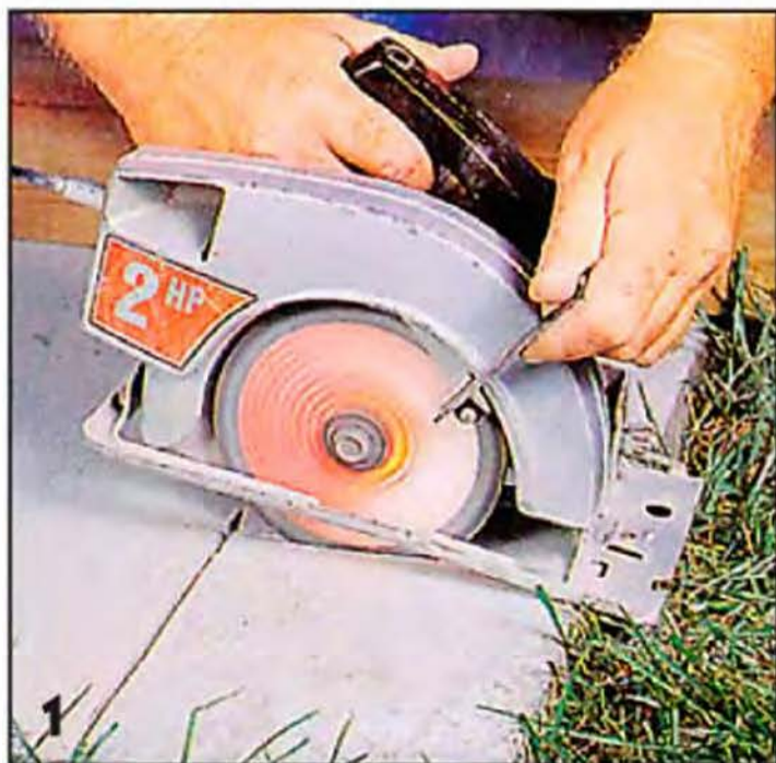
Работу начинают с укрепления бетонной плиты. Алмазный диск пилы довольно быстро режет бетон.
