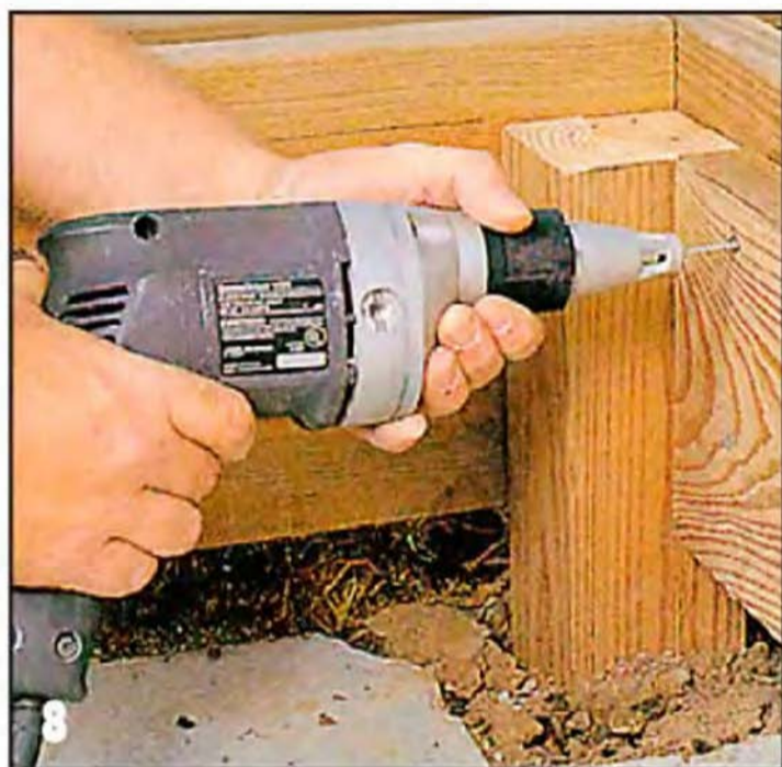
Изнутри наружный каркас усиливают крайними лагами (внутренним каркасом).
