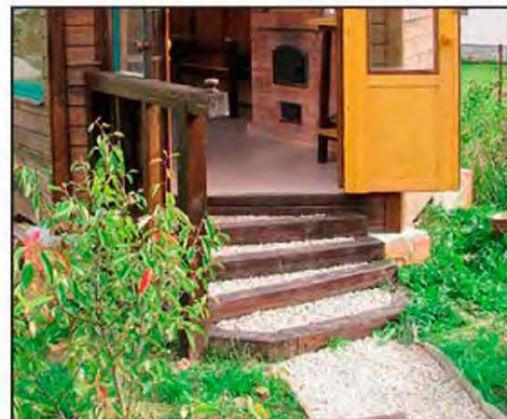
Засыпная лестница, используемая как заходная.
