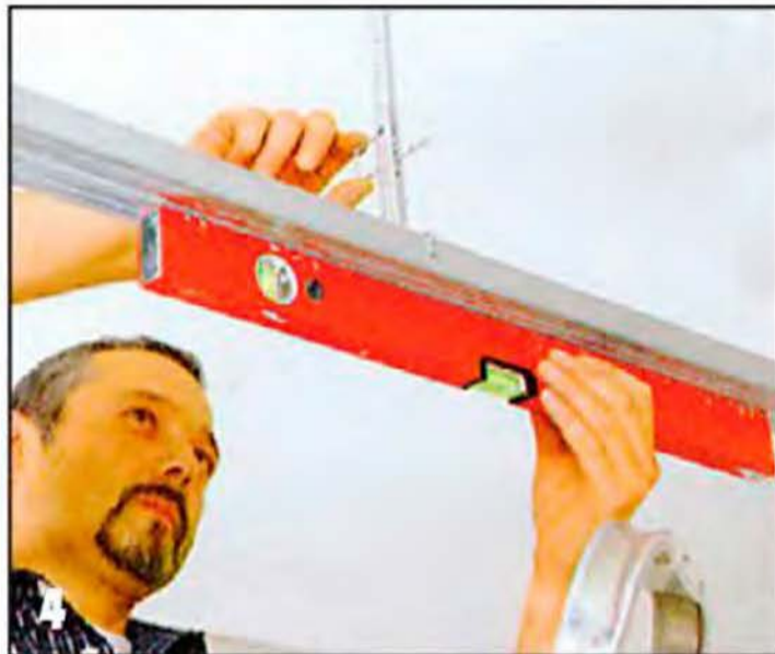
Выставив профили по уровню, их фиксируют в этом положении скобами, которые вставляют в юстировочные отверстия подвеса.
