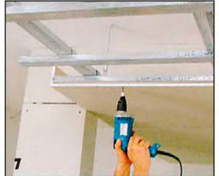
7 И в данном случае листы обшивки к каркасу крепят саморезами, а торцевые и боковые накладки шириной 10 см — ещё и монтажным клеем.
