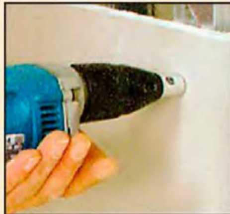
Специальный держатель отвёрточных насадок (бит) можно настроить так, чтобы головка вворачиваемого шурупа оказалась точно заподлицо с поверхностью гипсокартонной обшивки. В этом случае шуруп не прорвёт картонный слой листа.
