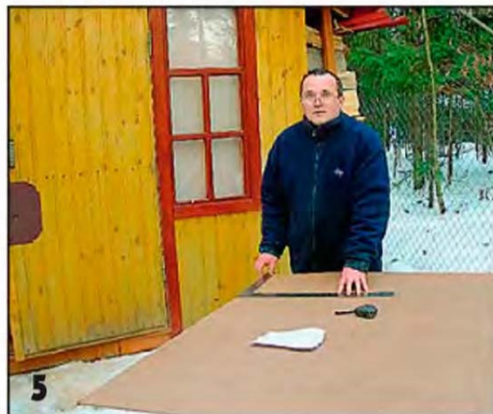
По расчётным размерам выкраиваем филёнки из ДВП.
