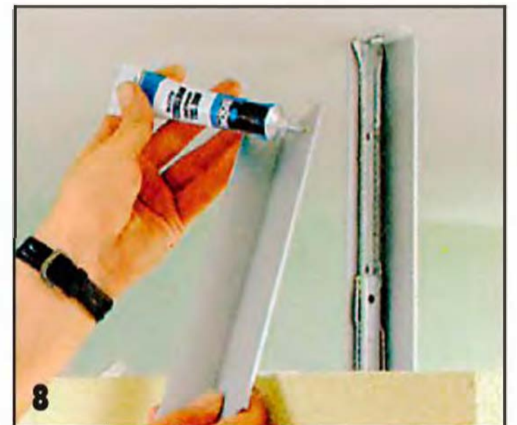
8 В завершение подвесы укрывают декоративными алюминиевыми экранами.
