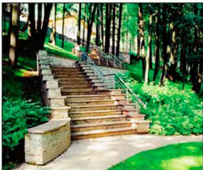
Малоступенчатая цельная межтеррасная лестница.
