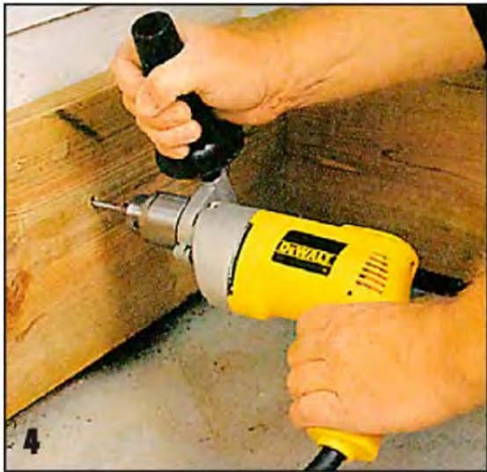
Заднюю доску наружного каркаса прихватывают к стене дома парой шурупов, а затем, просверлив четыре отверстия соответствующего диаметра, крепят доску анкерными болтами.
