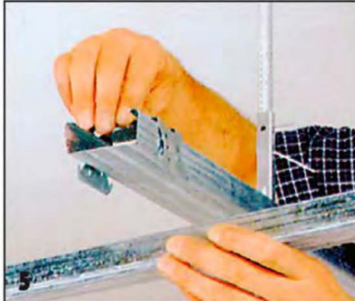
5 На оба уже установленных потолочных профиля ПП надевают соединительные профили,...
