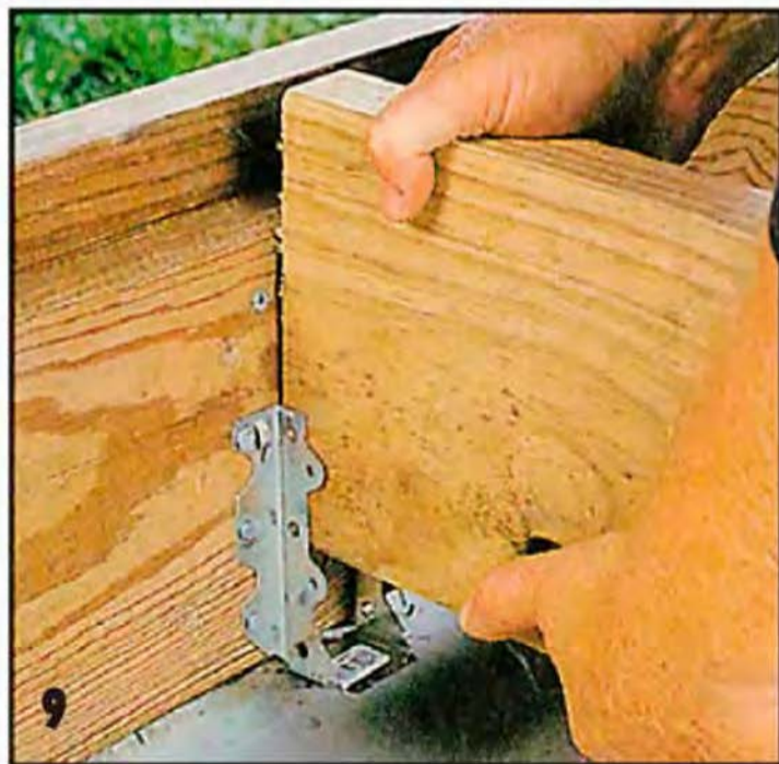
На передней и задней досках внутреннего каркаса по разметке крепят монтажные кронштейны под поперечные лаги.
