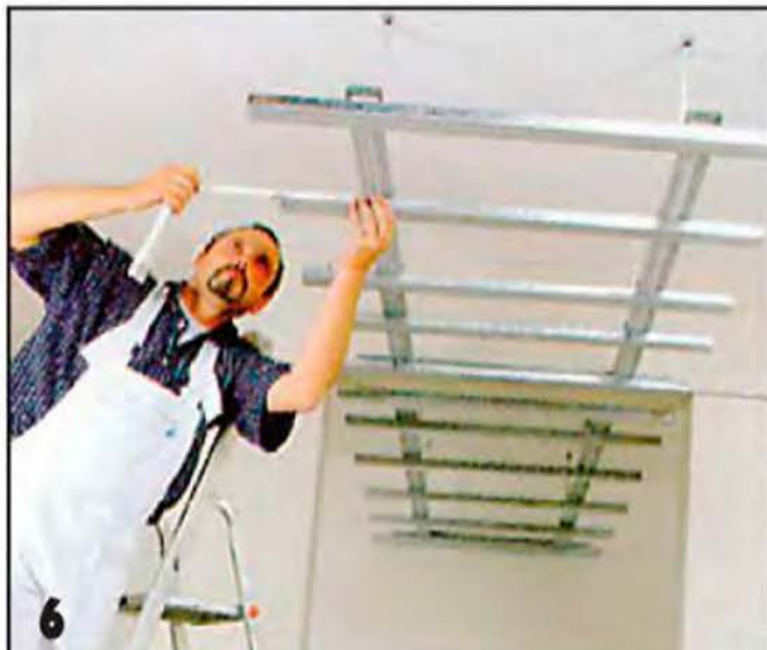
6 ...с помощью которых подвешивают несущие профили. Именно к последним и будут крепить гипсокартонные листы обшивки.
